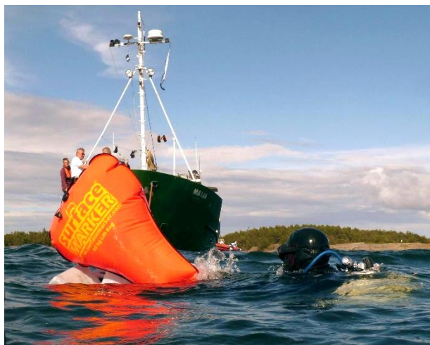
Kuva 6. Puistokalusteiden kuljetusta nostosäkillä
